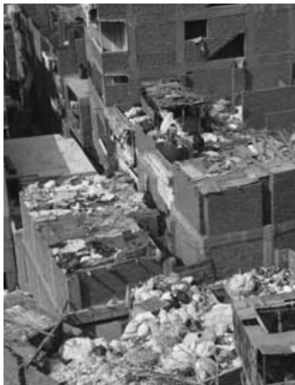
Müll auf den Dächern am Fuße des Muqattam-Berges.
